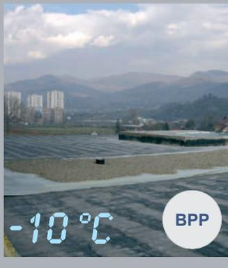
Le membrane impermeabili OLYMPIA sono realizzate con una miscela a base di bitume modificato con tecnopolimeri poliolefinici in un rapporto di formulazione ottimizzato, unita a un supporto in TNT di poliestere stabilizzato con fili di vetro. Queste membrane consentono di realizzare sistemi impermeabili per fondazioni o, in copertura, sistemi multistrato a vista, con finitura autoprotetta o sotto protezione pesante.
