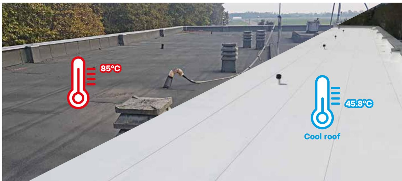
L'immagine pone in evidenza la differenza di temperatura superficiale tra impermeabilizzazione tradizionale e sistema con finitura Cool Roof
