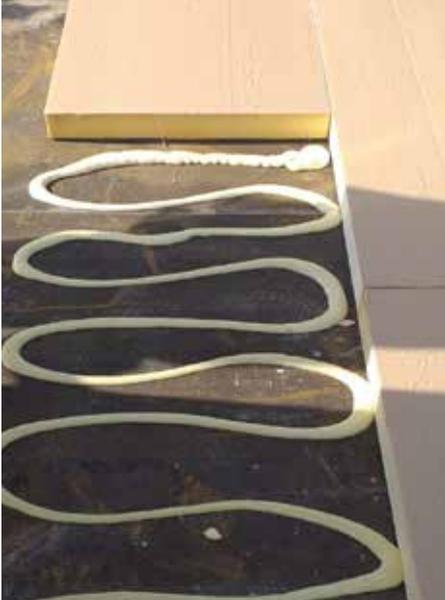
**Supra Stick Bond** è un adesivo monocomponente progettato specificamente per l'incollaggio professionale e rapido di una vasta gamma di pannelli isolanti e per applicazioni dirette su diversi supporti. Il sistema con contenitore pressurizzato ed erogatore a pistola consente un'applicazione precisa e senza sprechi, riducendo i tempi di intervento. La schiuma altamente adesiva, a rapida polimerizzazione, assicura un'ottima adesione del pannello nel tempo.
